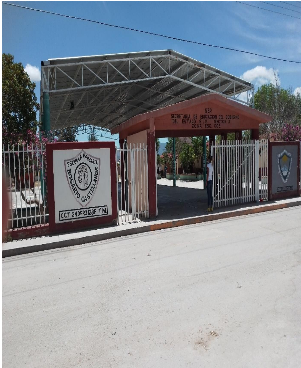
Fachada de la escuela primaria “Rossario Castellanos”
